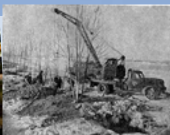
Строители и зимой сажали деревья вдоль трассы канала
